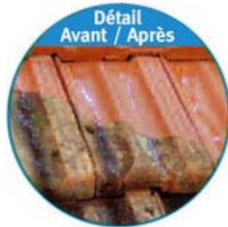
Rénovation de toiture
