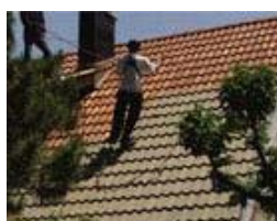
Mise en oeuvre
