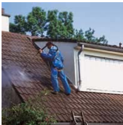
Nettoyage des toitures
